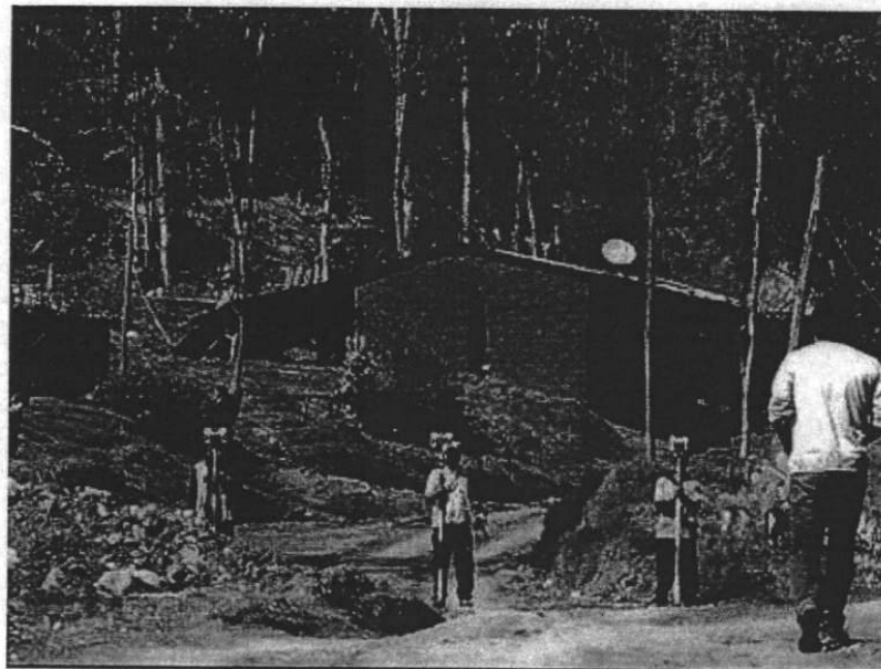
FOTO N° 14. LEVANTAMIENTO TOPOGRAFICO DE PLATAFORMA
