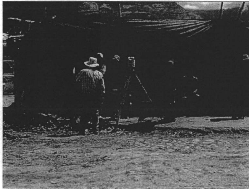
FOTO N° 5. TRABAJOS DE GEOREFERENCIACION –INICIO DE TRAMO
